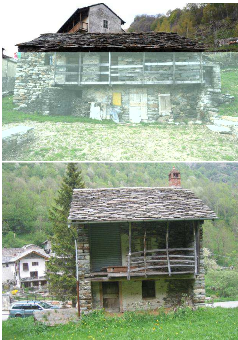
Figura 94: ballatoio con montanti lignei e parapetto in listelli orizzontali
