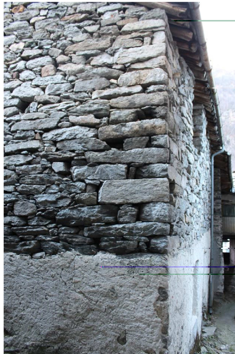
Figura 77: particolare dell'ammorsamento angolare
