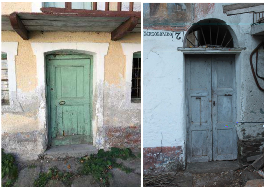
Figura 57 ingresso con fascia intonacata
