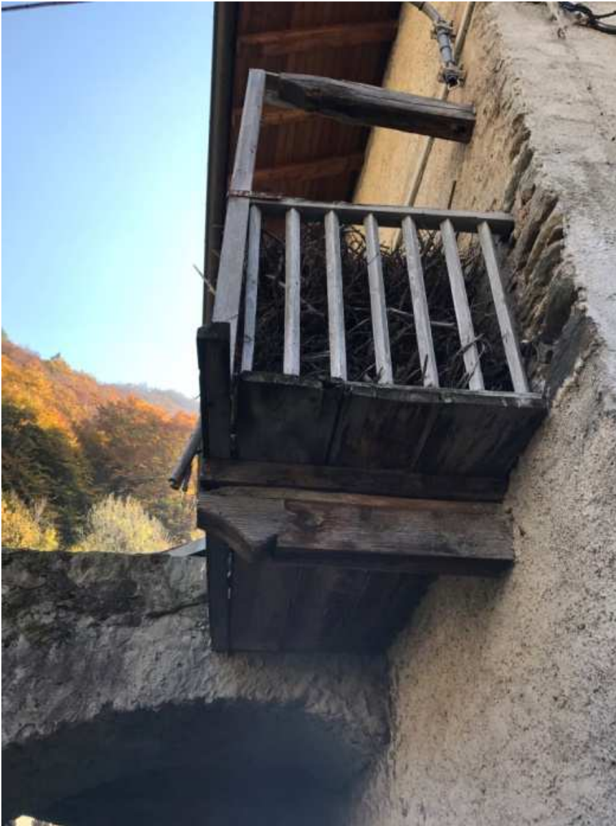
Figura 104: particolare dell'aggancio ballatoio-muratura-travi
