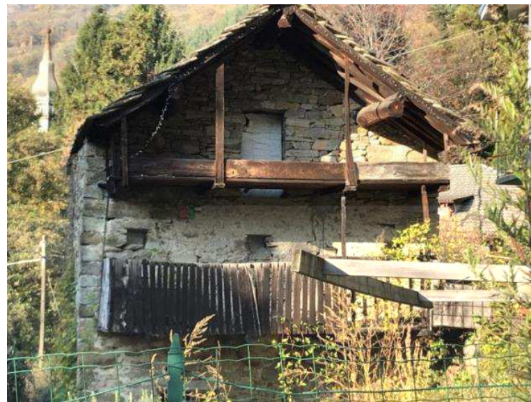
Figura 98: ballatoio all'ultimo piano con un'unica tavola lignea
