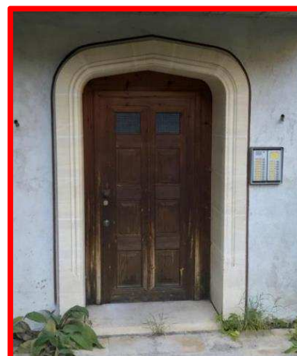
Figura 64 disegno non conforme alla tradizione costruttiva
