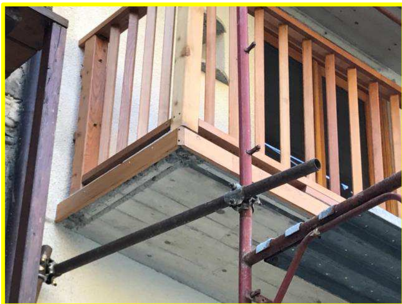
Figura 108 soletta in cls mascherata con profili lignei
