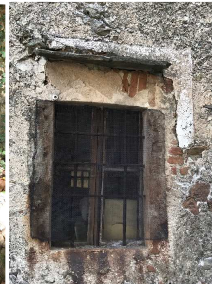
Figura 50: architrave in conci di mattoni
