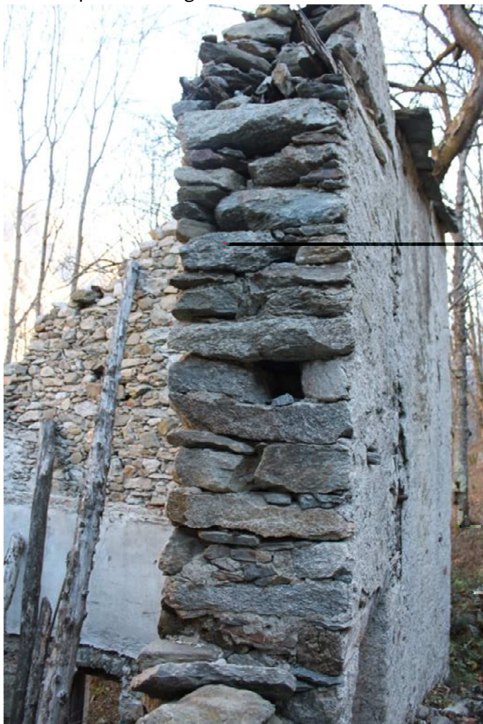
Figura 74: sezione trasversale a paramenti ammassati – Frazione Borno Noasca
