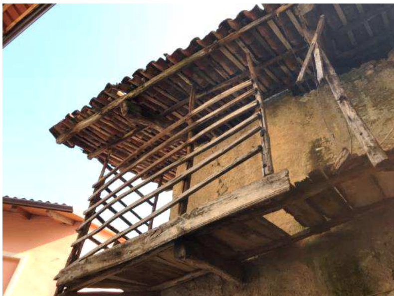
Figura 102: particolare dell'aggancio tetto montanti-ballatoio
