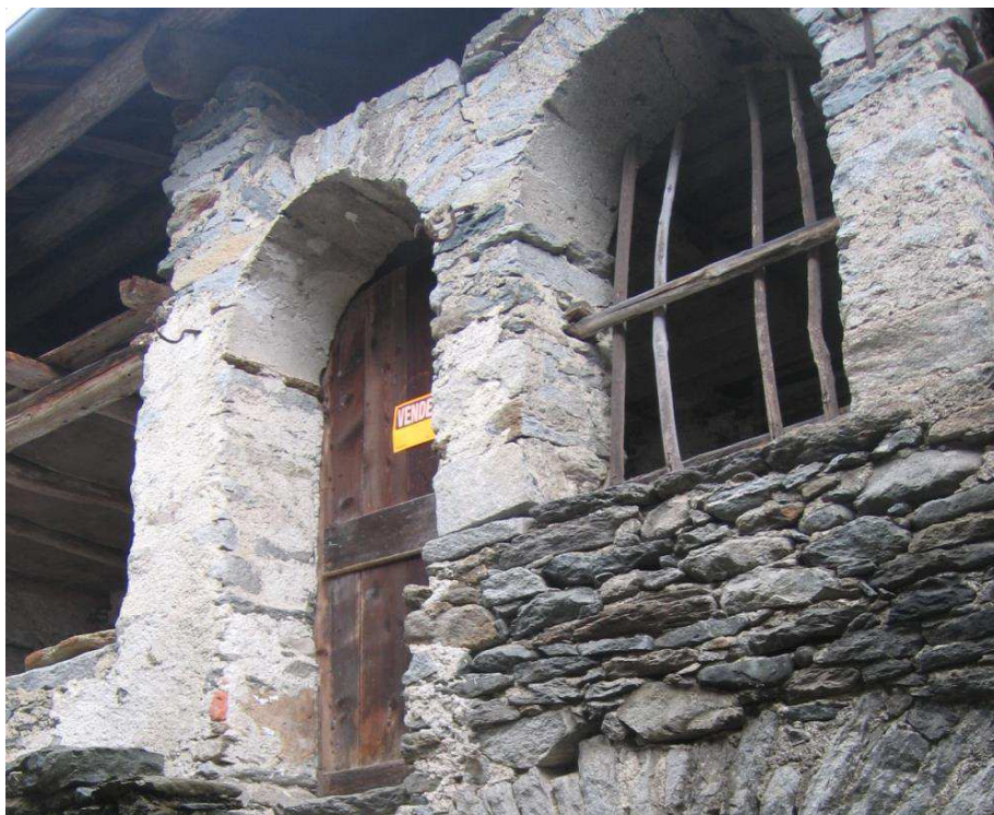
Figura 51 portone di ingresso in ambito rurale
