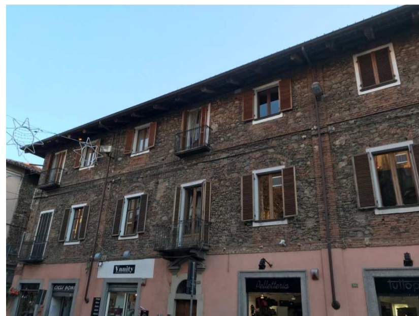
Figura 83: Castellamonte. Muratura in pietra e laterizio
