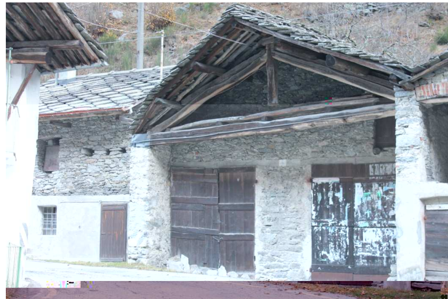
Figura 10: sporto del tetto realizzato con capriata – Frazione Frera Inferiore tra Locana e Noasca
