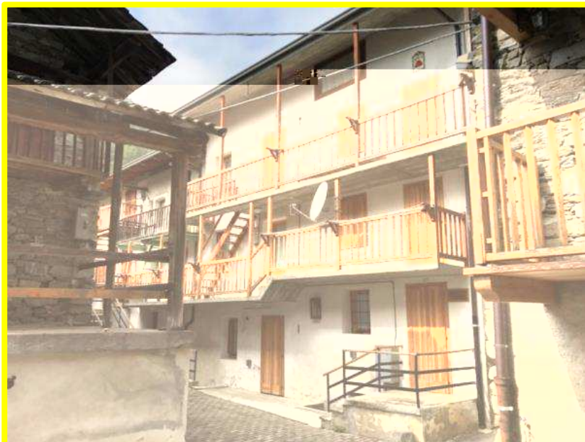
Figura 108 soletta in cls mascherata con profili lignei
