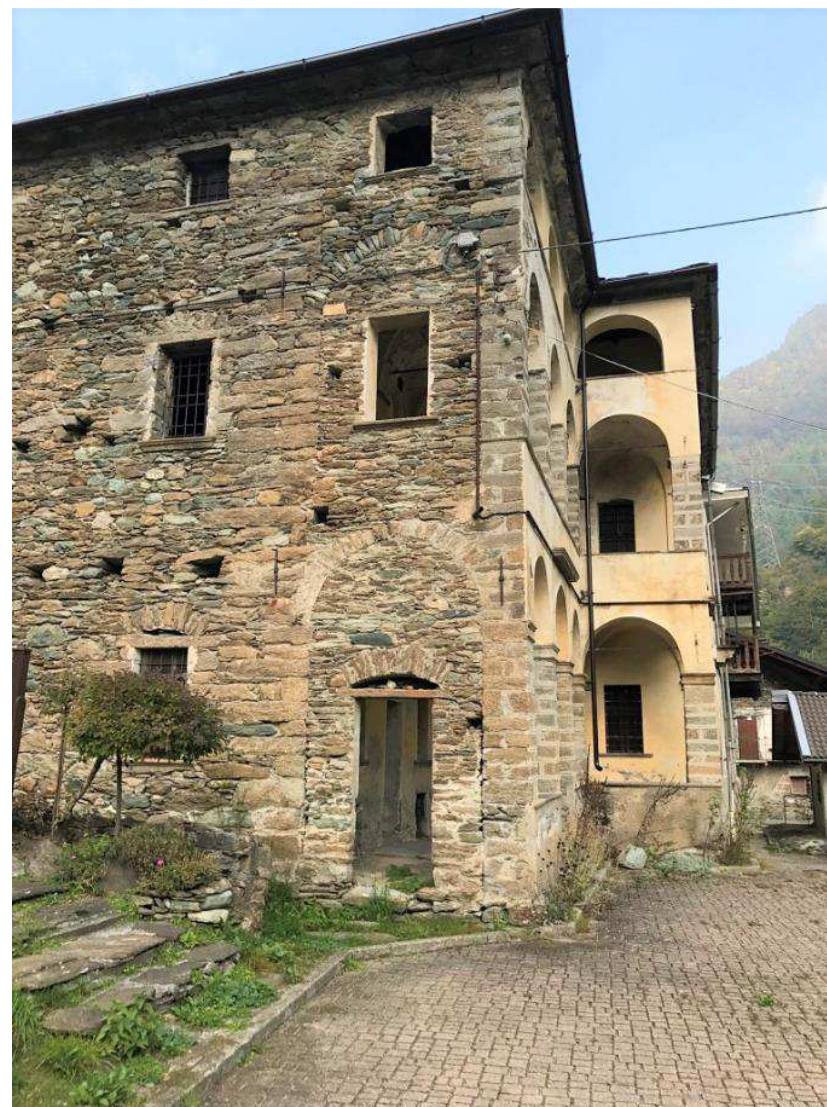
Figura 44: lastra di pietra sormontata da architrave in conci di pietra.
