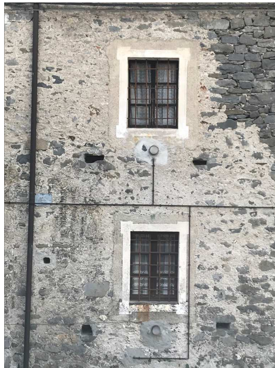
Figura 73: corsi irregolari con posa orizzontale/verticale, scaglie, parzialmente intonacata Meugliano
