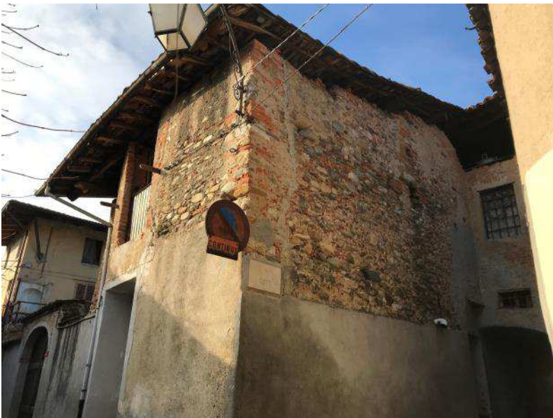
Figura 89: muratura in pietrame con ricorsi in laterizio
