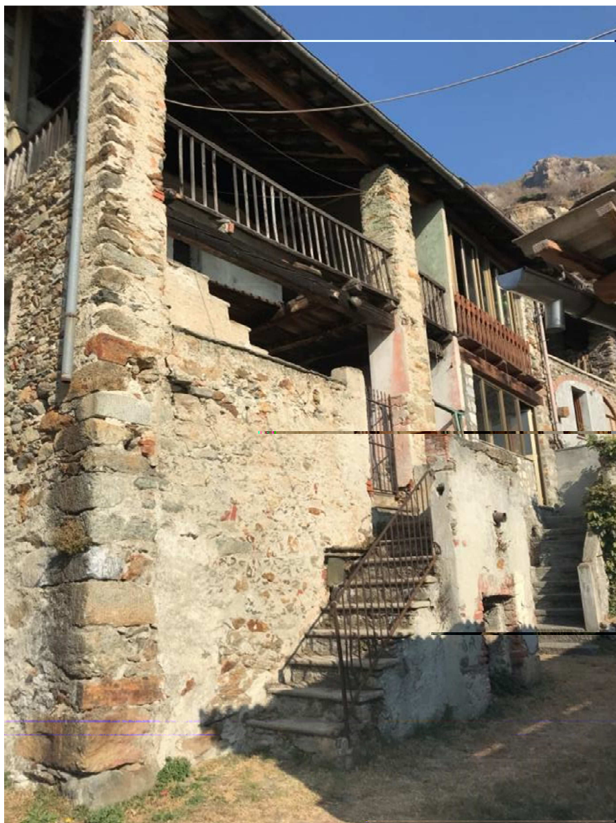
Figura 105 loggiato con piano terra chiuso da muratura
