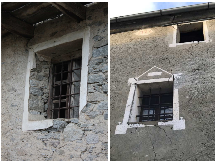
Figura 33: vano in muratura e cornice intonacata
