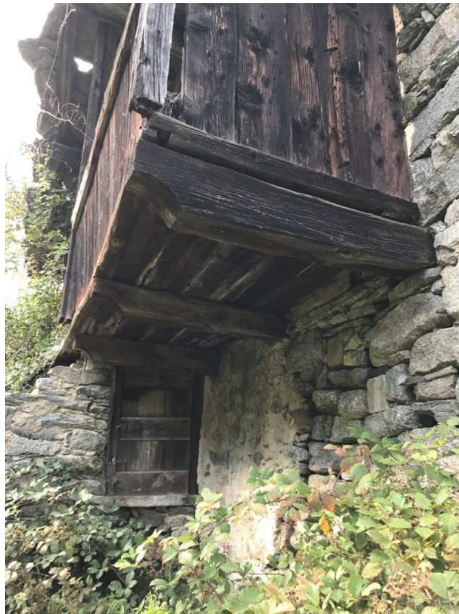
Figura 103: particolare dell'aggancio travi - muratura-ballatoio
