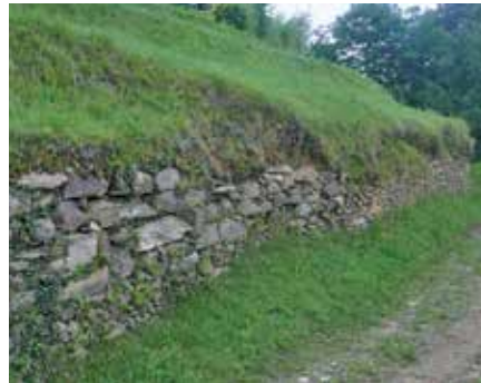
• Muro di sostegno di scarpata.
