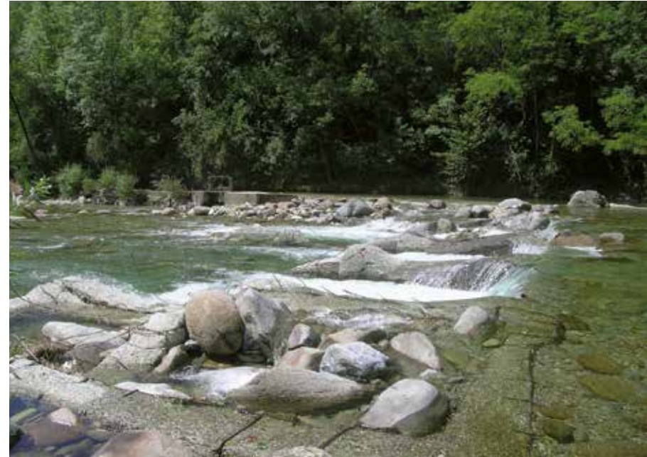
• Comune di Vistrorio: particolare paratoia di scarico a valle traversa di presa.
