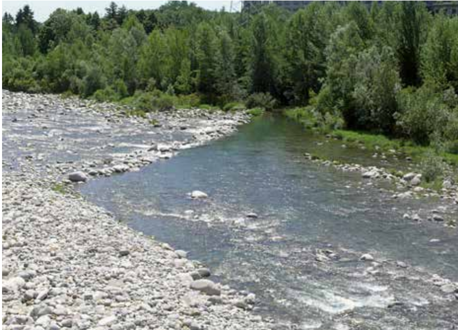
• Torrente Orco: sbarramento precario.
