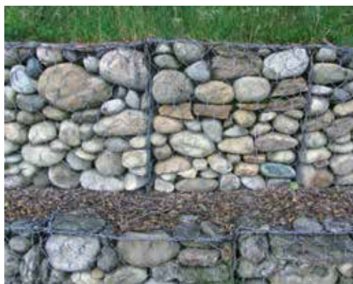
• Gabbionata Di recente realizzazione.
