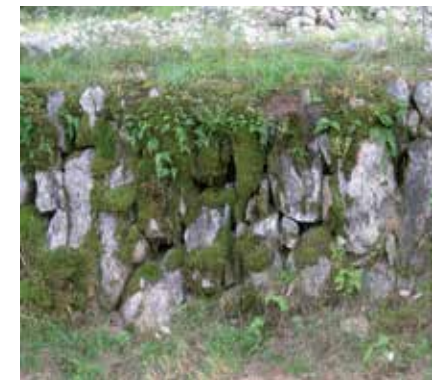
• Particolari di murature da spietramento di pregevole e sapiente fattura.
