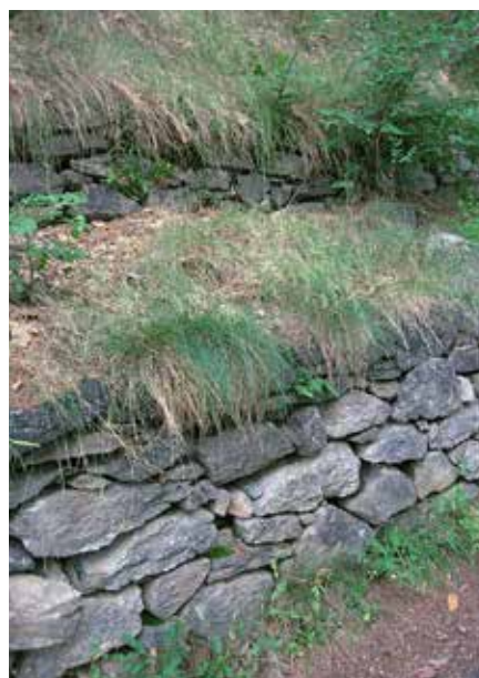
• Muro in pietra a secco Per ridurre le altezze, viene utilizzata la soluzione di due muretti.
