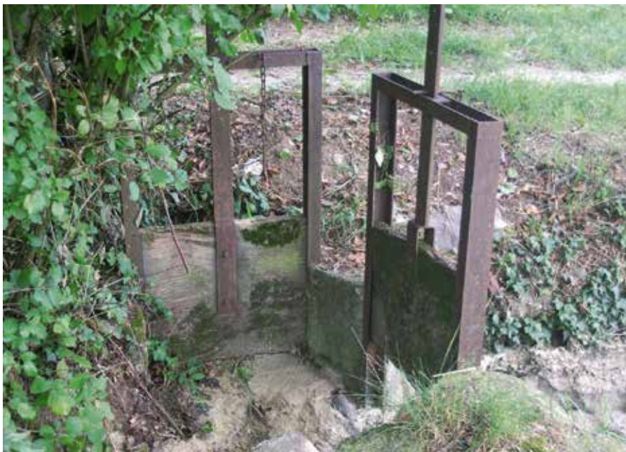
• Particolari di bocchette di derivazione.
