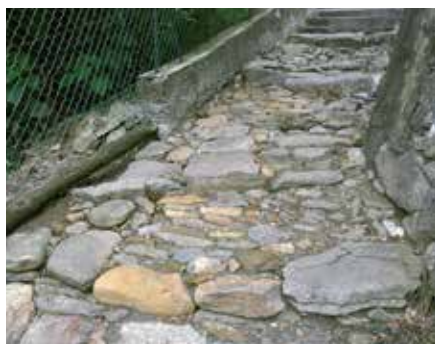
• Pavimentazione in selciato.
