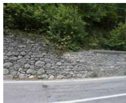
• Sopraelevazione o copertina in cemento.
