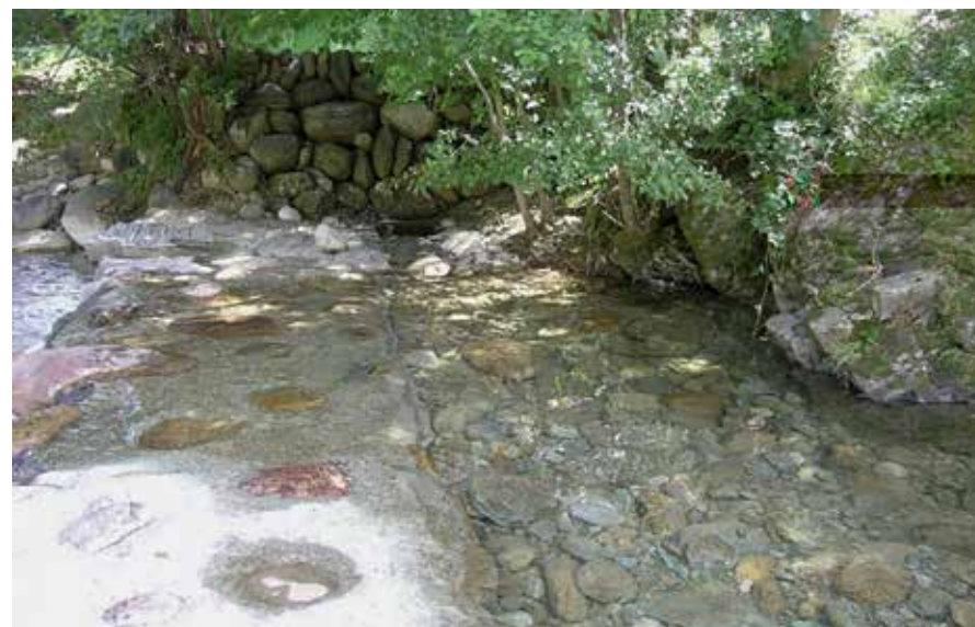
• Particolare traversa di presa.
