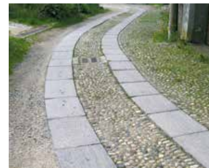
• Acciottolato con lastre disposte su due corsi.
