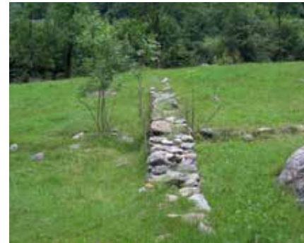
• Muro a secco di delimitazione delle proprietà.
