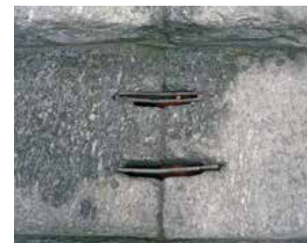
• Particolare caditoia in pietra.
