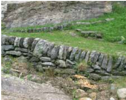
• Muro di contenimento presso un sentiero.
