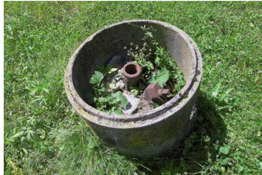
• Valle Orco – Comune di Sparone: particolare bocchetta per irrigazione a pioggia.
