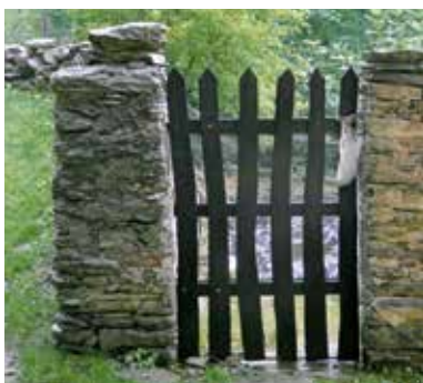
• Muretto in pietra di recinzione di orto.
