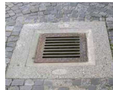
• Particolare caditoia in pietra.
