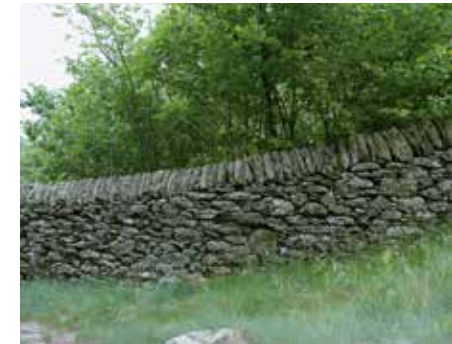
• Coronamento superiore in lastre posate a coltello.
