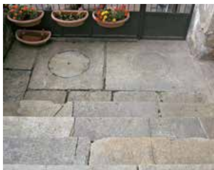
• Pavimentazione in selciato.
