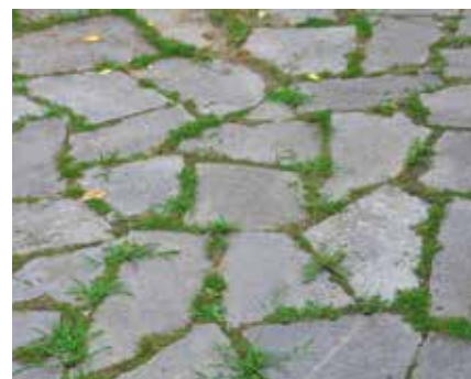
• Pavimentazione in lastricato con giunti inerbiti..
